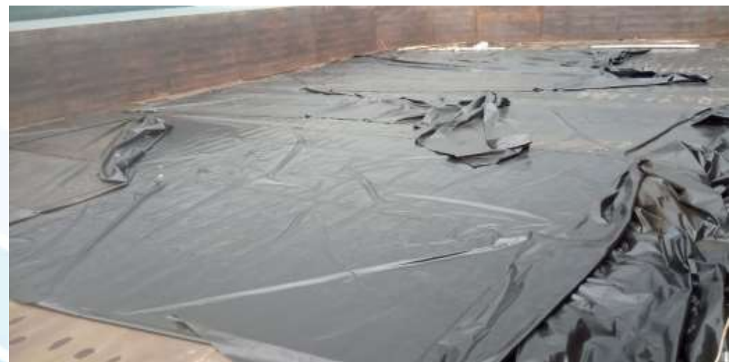
Pendasaran Kapal Tongkang dengan geomembrane – 3 unit PT. SBM. Kalimantan Selatan
