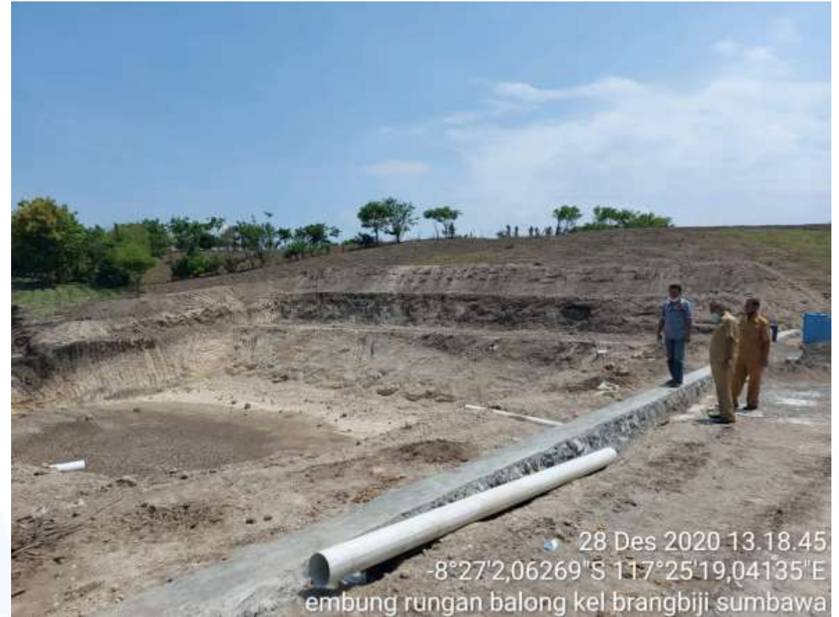
Embung Rungan Balong Kel. Brangbiji Sumbawa
