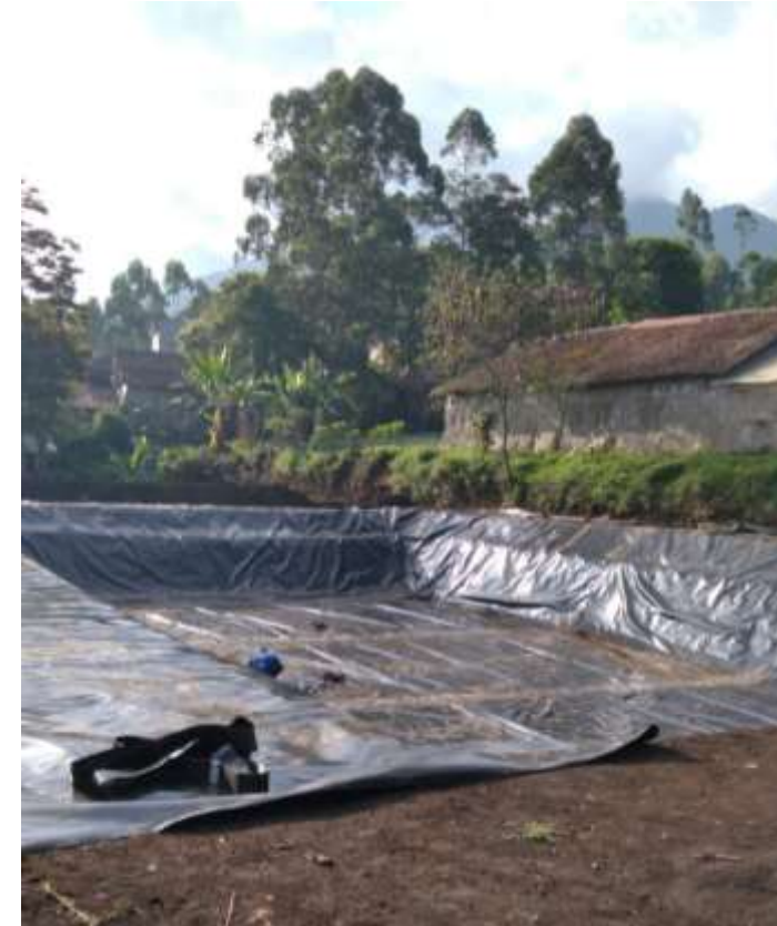
Grace Rose Farm Bandung Geomembrane 0.75 untuk persediaan air kebun
