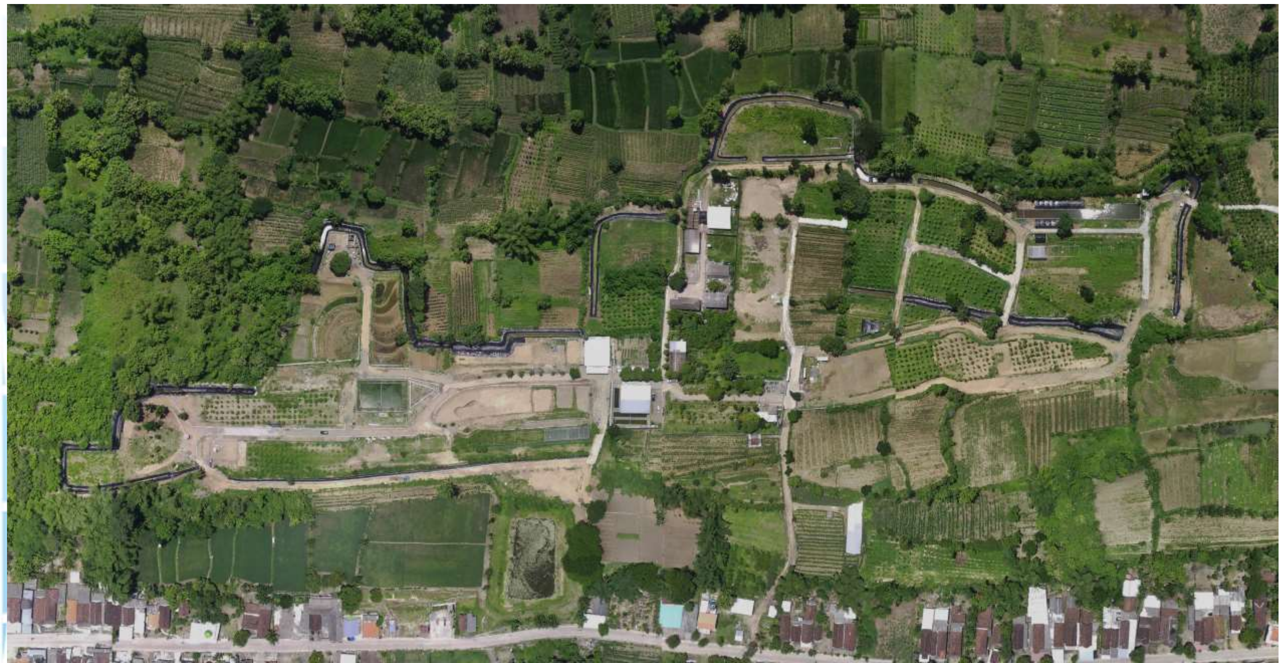
Proyek Irigasi , Perkebunan HRL Mondoluku, Gresik
